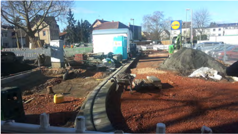
Die Umbaumaßnahmen des ersten Bauabschnitts stehen kurz vor dem Abschluss.
