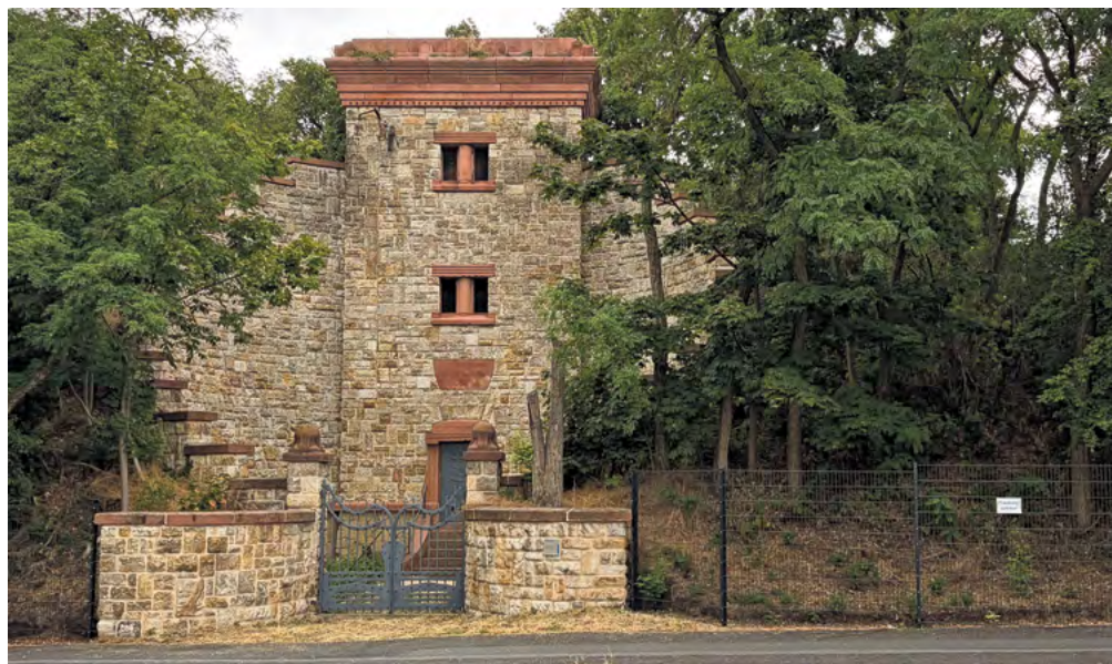
Der historische Wasserhochbehälter in der Kreuzstraße 10 in Mainz-Mombach ist ein 1904 erbautes Kulturdenkmal
